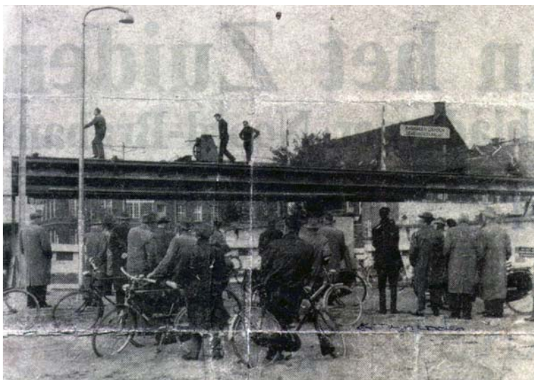
Deze foto werd op 23 oktober 1962 geplaatst in het Nieuwsblad van het Zuiden tijdens de aanleg van het viaduct aan de Gasthuisstraat. Op de voorgrond staat Janus, tegen zijn fiets geleund, te kijken. (Zie detail volgende bladzijde)
